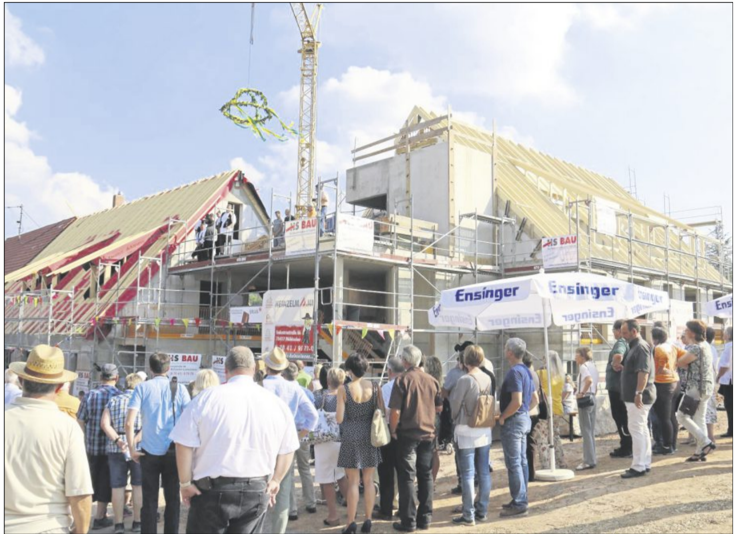
Die Richtkrone wird hochgezogen, der Rohbau der Familienherberge Lebensweg in Schützingen steht.
